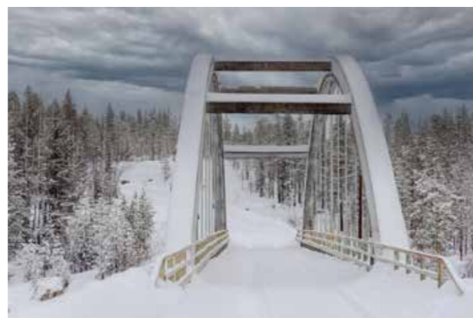
Die Brücke über die Benbrytefossen
